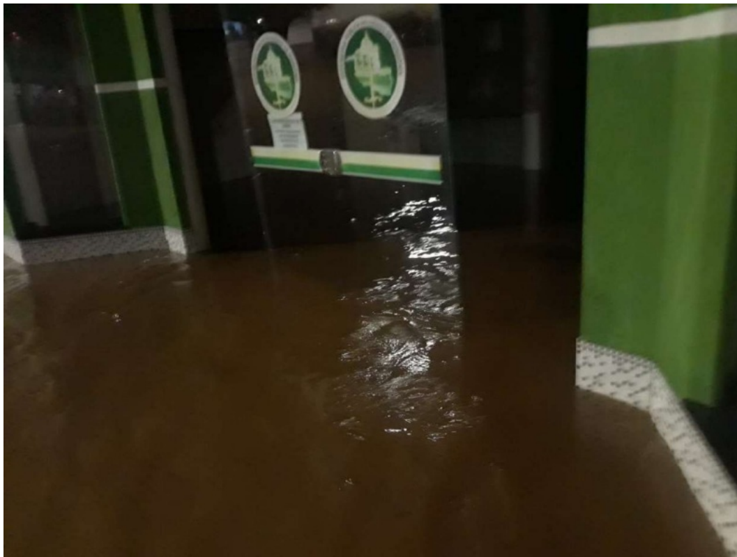
Figura 1: Fachada do imóvel inundada
