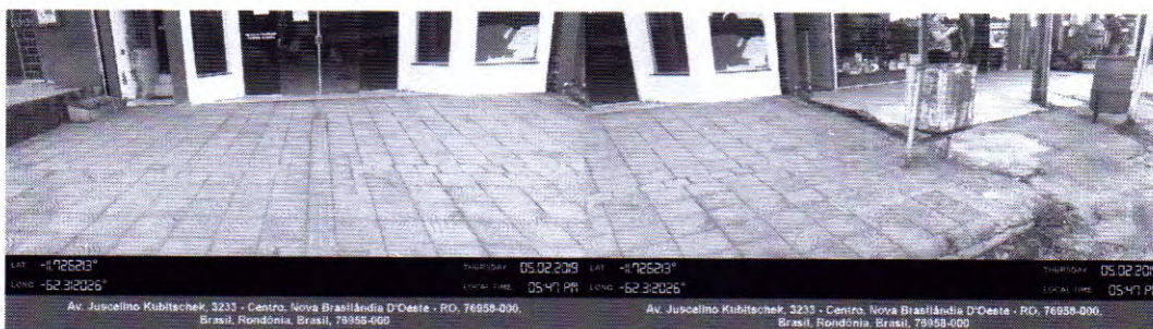
Figura 3 - Vista calçada e acessibilidade do imóvel.
