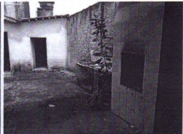
Imagem 12 (vista lateral do incinerador, localizado na porção inferior do imóvel)
