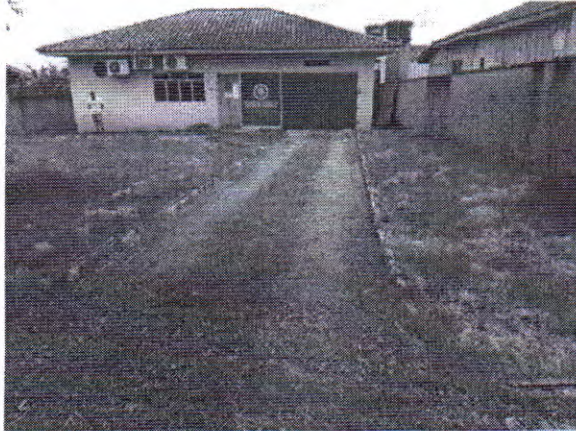
Imagem 03 (Irregularidades/desníveis no piso, ausência de piso direcional/tátil).
