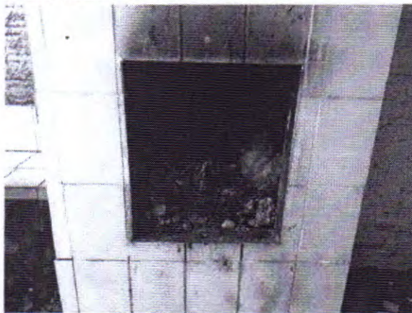
Imagem 11 (vista frontal do incinerador de lixo)
