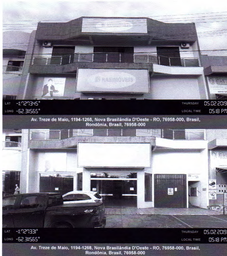
Figura 1 Vista da fachada do imóvel (ao centro), em área comercial da cidade.
