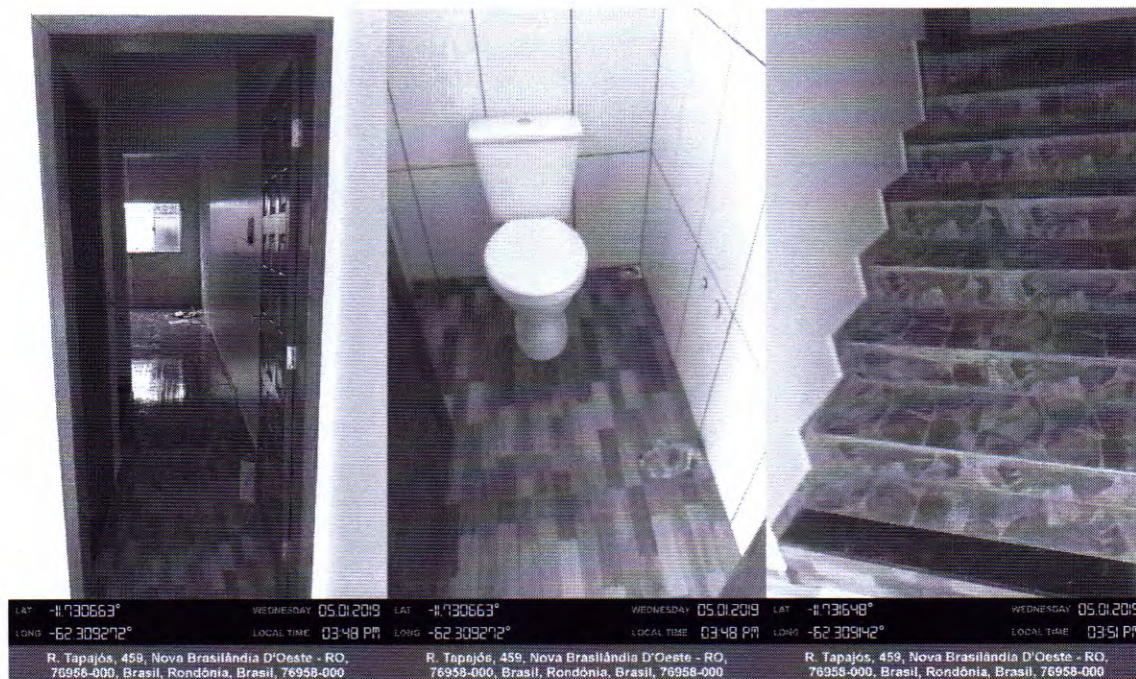
Figura 5 Vista entrada corredor pós recepção, banheiro assistidos e escada para acesso ao piso superior do hall de acesso e salas de assessoria, tudo em alvenaria.
