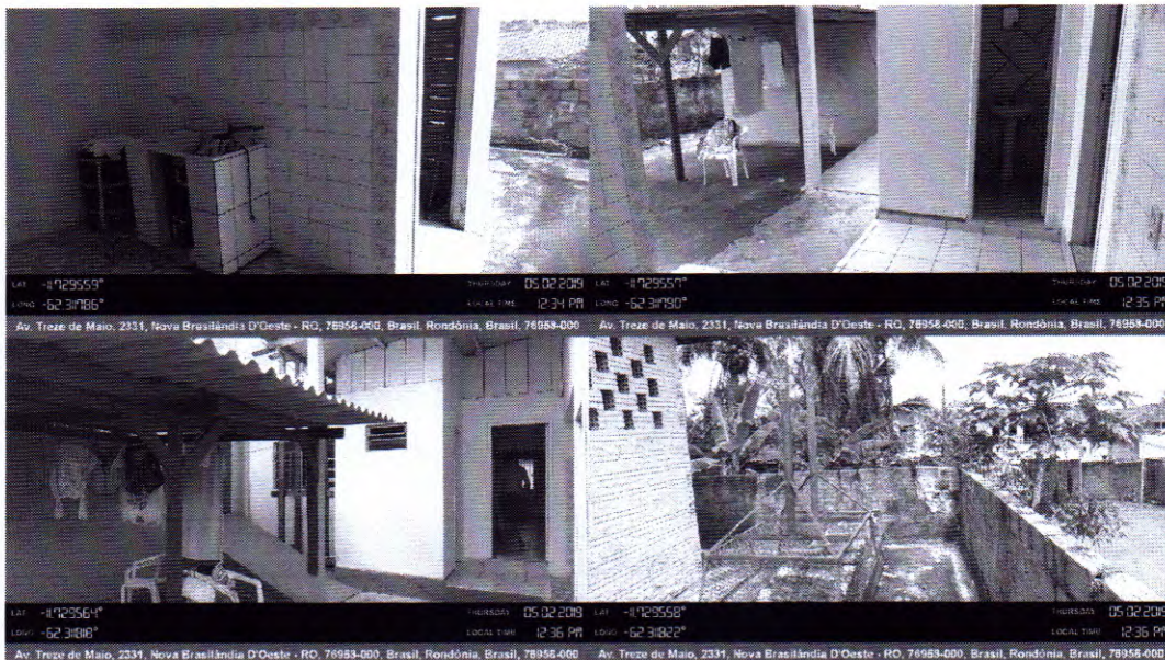
Figuras 11 - Vistas área de serviço com depósito ao fundo, vista da entrada do banheiro que pode servir aos servidores, vista da área externa coberta e vista dos fundos com o vizinho da direita do imóvel e dos fundos do terreno..
