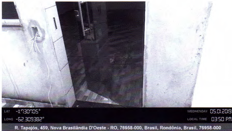
Figura 9 - Vista externa da porta de entrada entre área interna e área externa de serviço com porta de vidro temperado.
