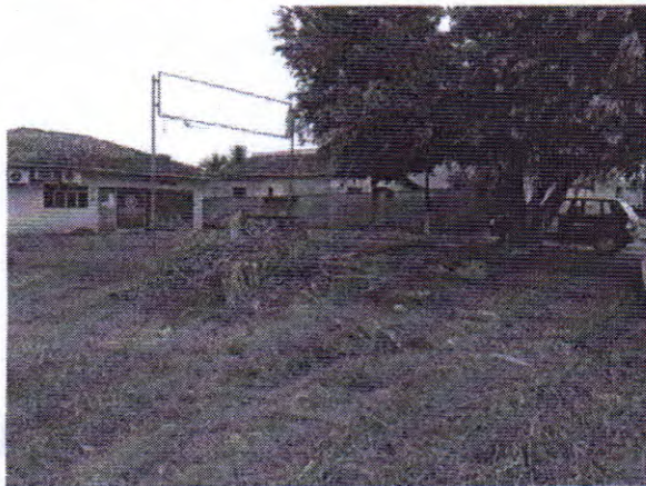
Imagem 01 (vista lateral do imóvel da DPE Nova Brasilândia)
