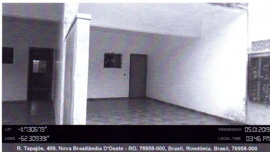
Figura 4 Vista da entrada da garagem.
