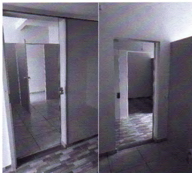
Figura 4 - Comprovação de acabamentos – Vista do corredor de atendimento inferior com acessibilidade ao WC PNE e vista para Sala do Administrativo e inversa.
