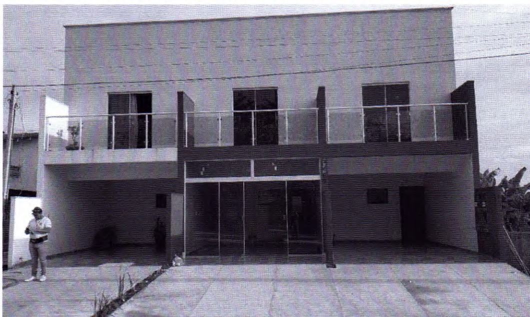
Figura 1 - Comprovação de como se encontra o acabamento do imóvel já ligado na rede elétrica..
