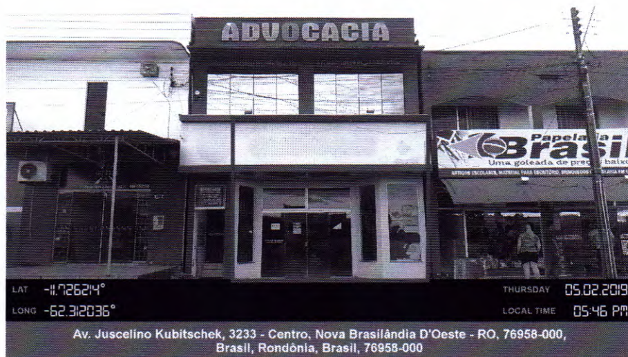
Figura 1 Vista da fachada do imóvel (ao centro), em área comercial da cidade.
